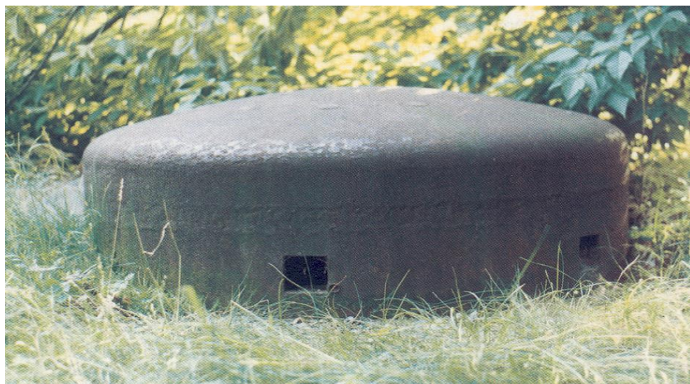
Ryc. 2. Pancerna kopuła obserwacyjna produkcji Zakładów Ostrowieckich, wmontowana w 1935 r. w jednym z fortów Twierdzy Modlin. Zbiory autora.
