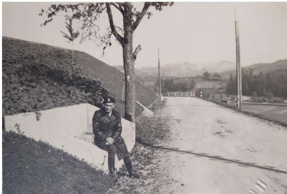
Ryc. 2. Por. Jan Różycki wyraźnie pozuje, siedząc przy drodze „w skrzyni na grysy w skarpie”, jak sam napisał na odwrocie zdjęcia, gdy po wojnie wykorzystał je jako ilustrację techniki wzmacniającej wał drogowy (Szwajcaria, sierpień 1940 r., archiwum rodzinne).
