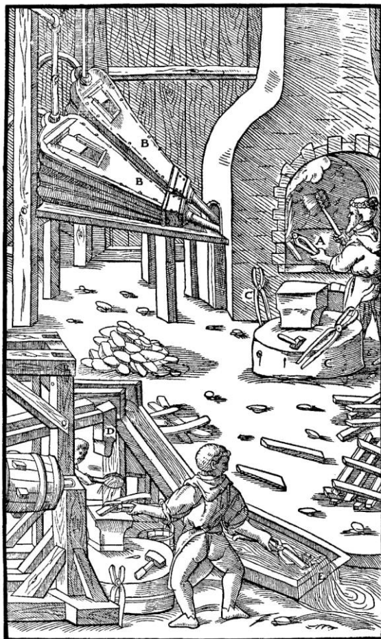
Ryc. 2. Piec kowalski i miechy wg G. Agricoli (1556). Na pierwszym planie młot podrzutowy.
